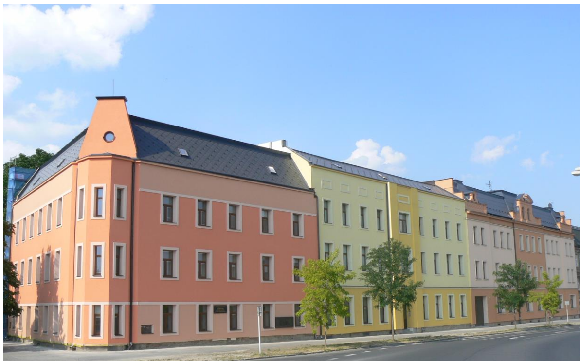
Opravená budova na Revoluční ulici
