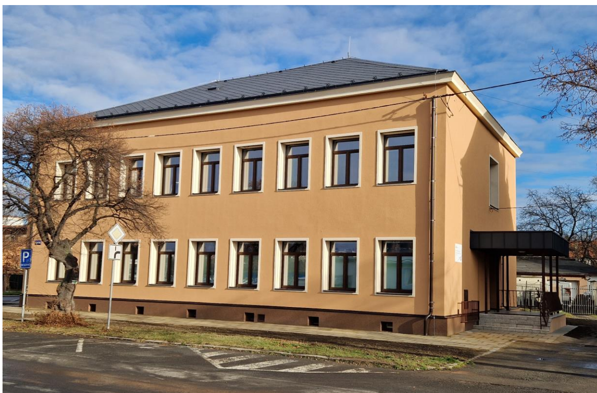
Opravená budova na Nádražní ulici
